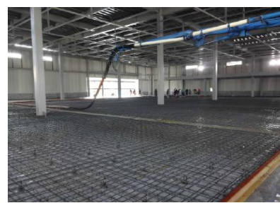
工場建設状況 (2015年12月1日時点) 土間コンクリート打設
