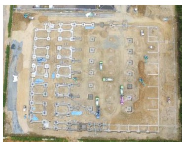
工場建設状況 (2015年9月30日時点) 基礎配筋
