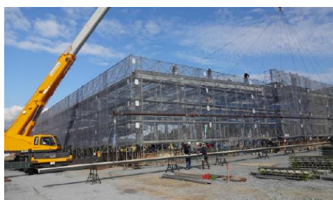
工場建設状況 (2015年11月6日時点) 鉄骨建方
